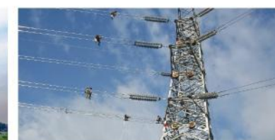
承德东-阳乐双回500kV碳纤维导线线路工程
